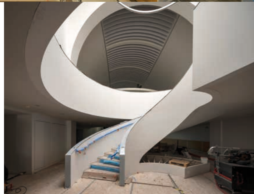
Musée national de la Marine, Paris. Chantier de rénovation, Palais de Chaillot, Escalier vers la mezzanine en galerie Davioud. 04/04/2023 ; h2o architectes et Snøhetta. © Patrick Tourneboeuf/OPPIC/Tendance Floue
