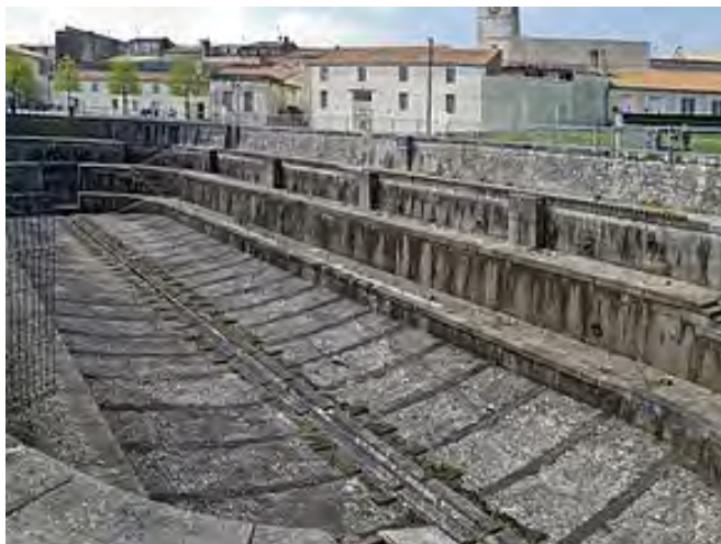
Forme de radoub
