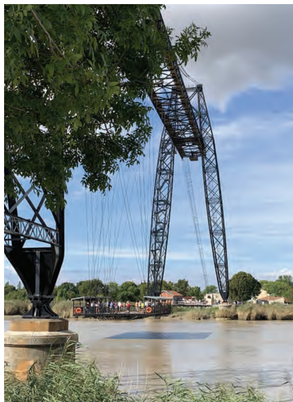
Le Pont Transbordeur
