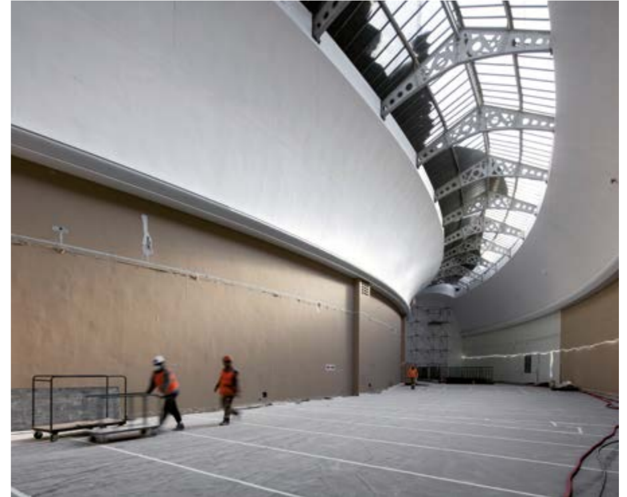
▼ Chantier de rénovation à Chaillot ©Patrick Tourneboeuf / OPPIC / Tendance Floue
