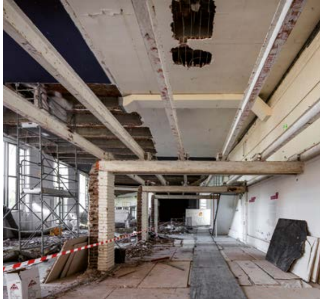
▼ Chantier de rénovation à Chaillot ©Patrick Tourneboeuf / OPPIC / Tendance Floue
