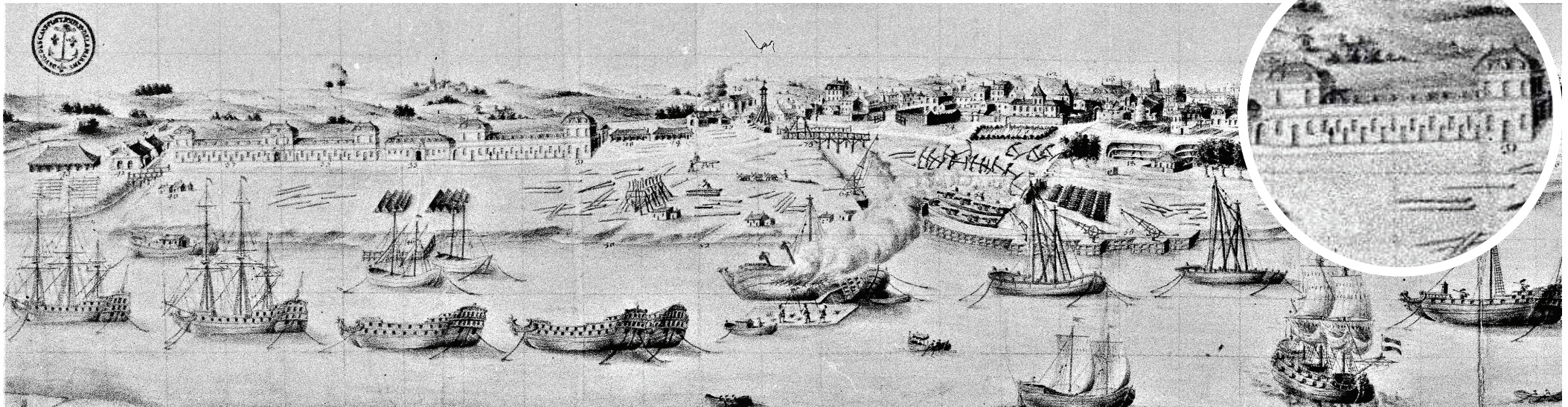
Plan de Rochefort dressé pour montrer la forme du retranchement, XVIII e siècle. Service Historique de la Défense, S.H.M. Extrait du Manuscrit 144 © MnM | SHD
