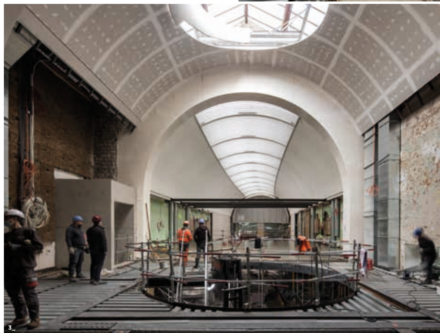
Musée national de la Marine, Paris. Chantier de rénovation. Palais de Chaillot ; Rez-de-chaussée. h2o architectes et Snøhetta ©Patrick Tourneboeuf/OPPIC/Tendance Floue 1_16/01/2020 2 et 3_15/02/2022
